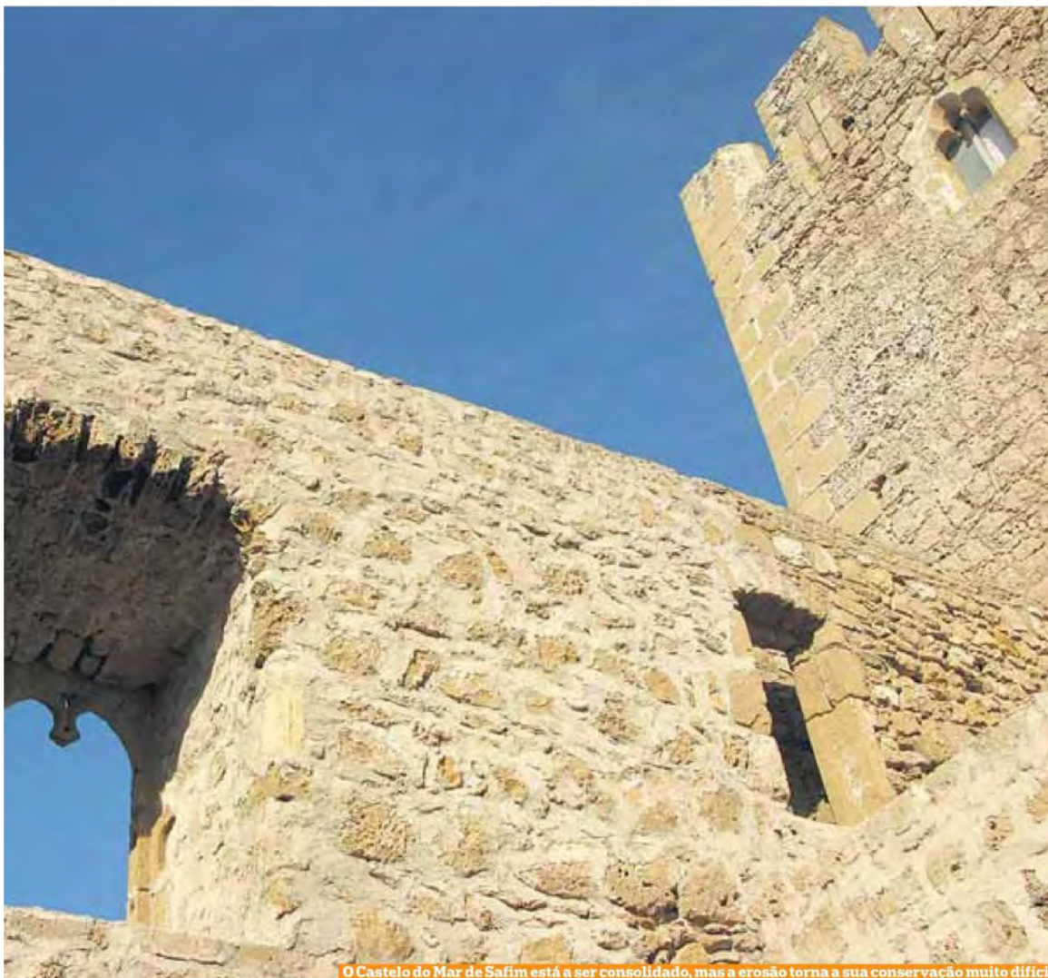
O Castelo do Mar de Safim está a ser consolidado, mas a erosão torna a sua conservação muito difícil
